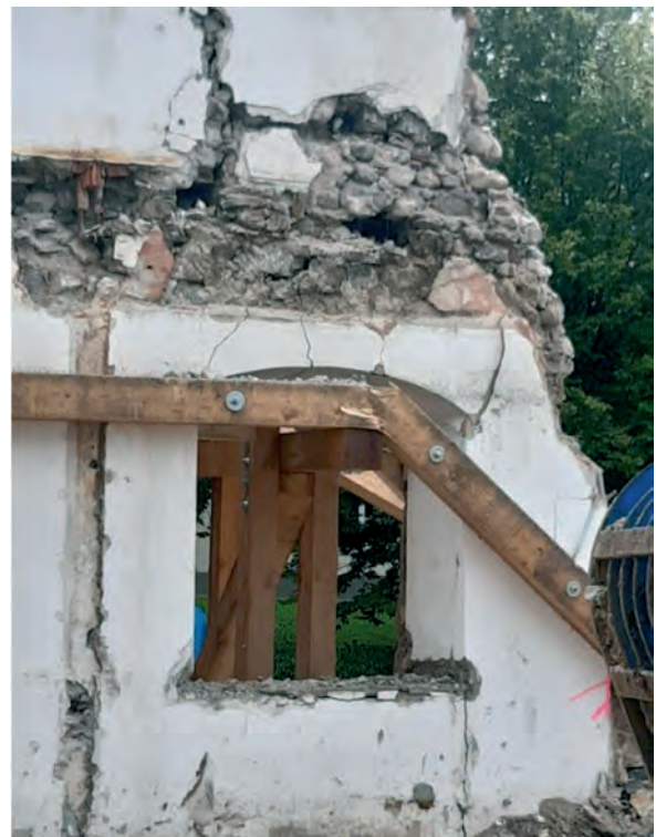
– Abbruchstelle Westfassade Innenansicht –
