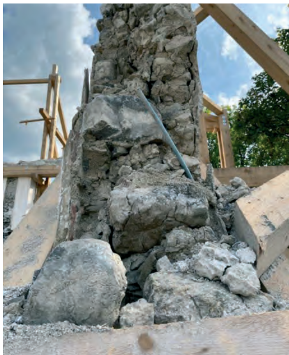
– Abbruchstelle Detail Wandaufbau –
